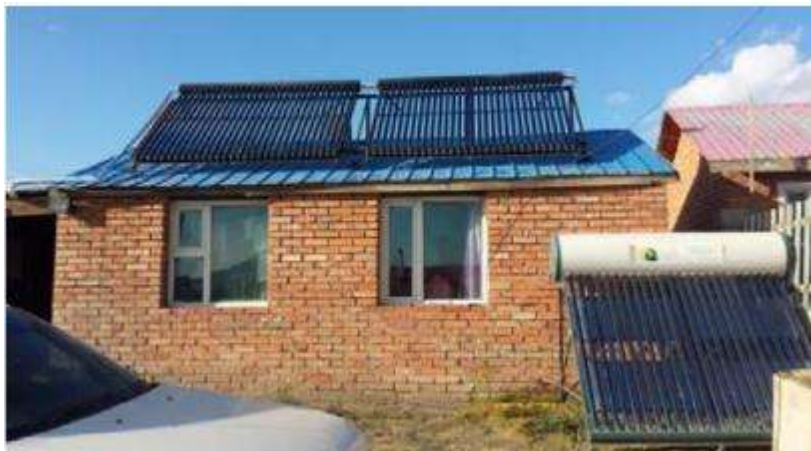
Бага чадлын нарны халаалтын системийн суурилагдсан байдал /29м2/
